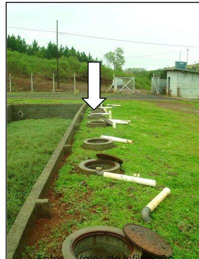
Fotos - Valas de Infiltração
